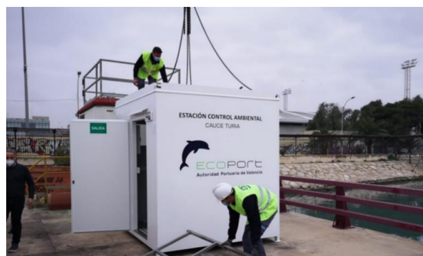
图 7-10 瓦伦西亚港环境监测控制室
